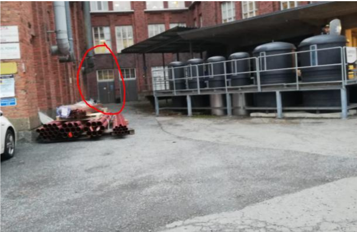
OVI 2. oven takana käytävä vasemmalle.
